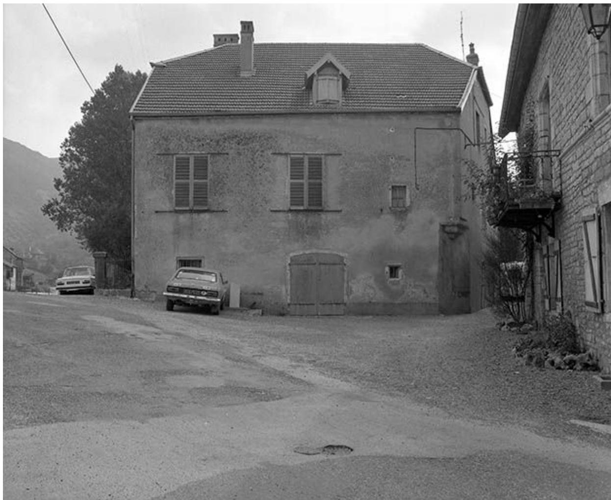
Façade latérale droite.
