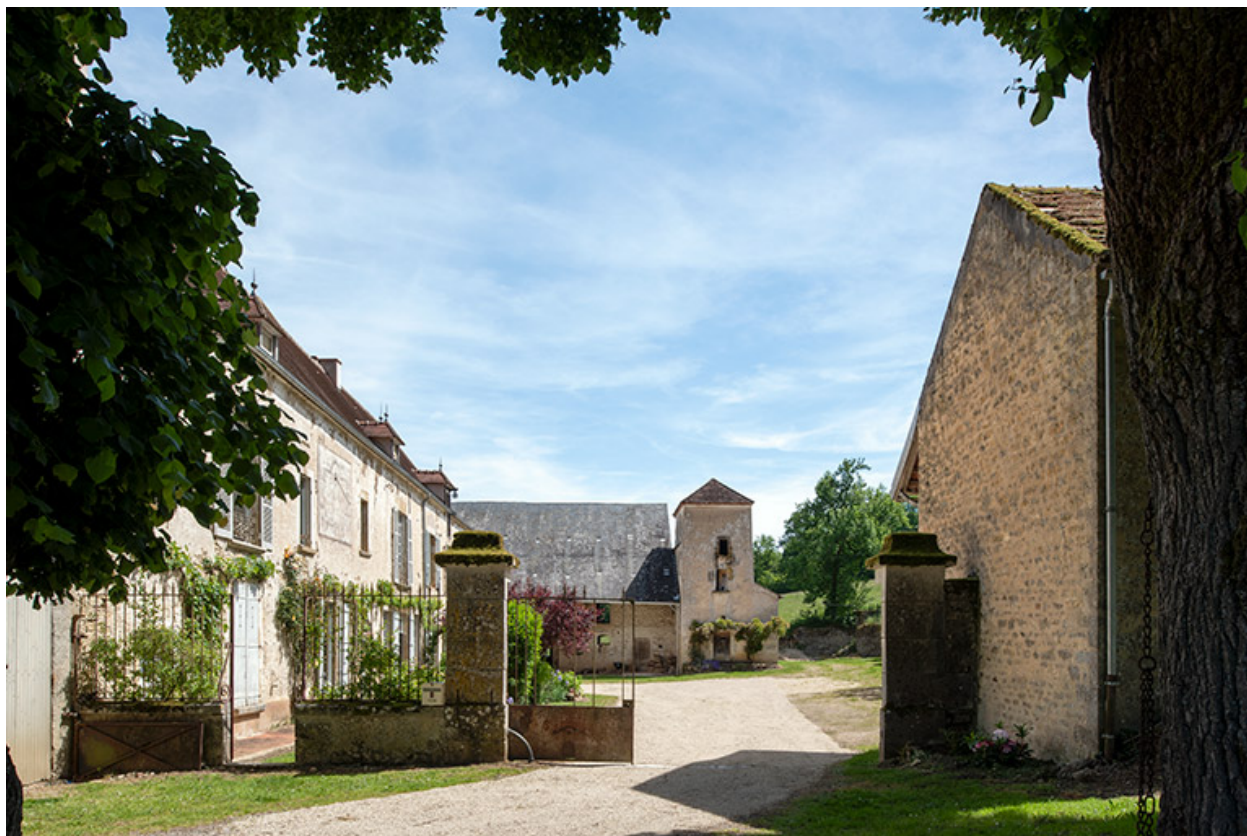
L'ensemble de la cour depuis l'entrée.
