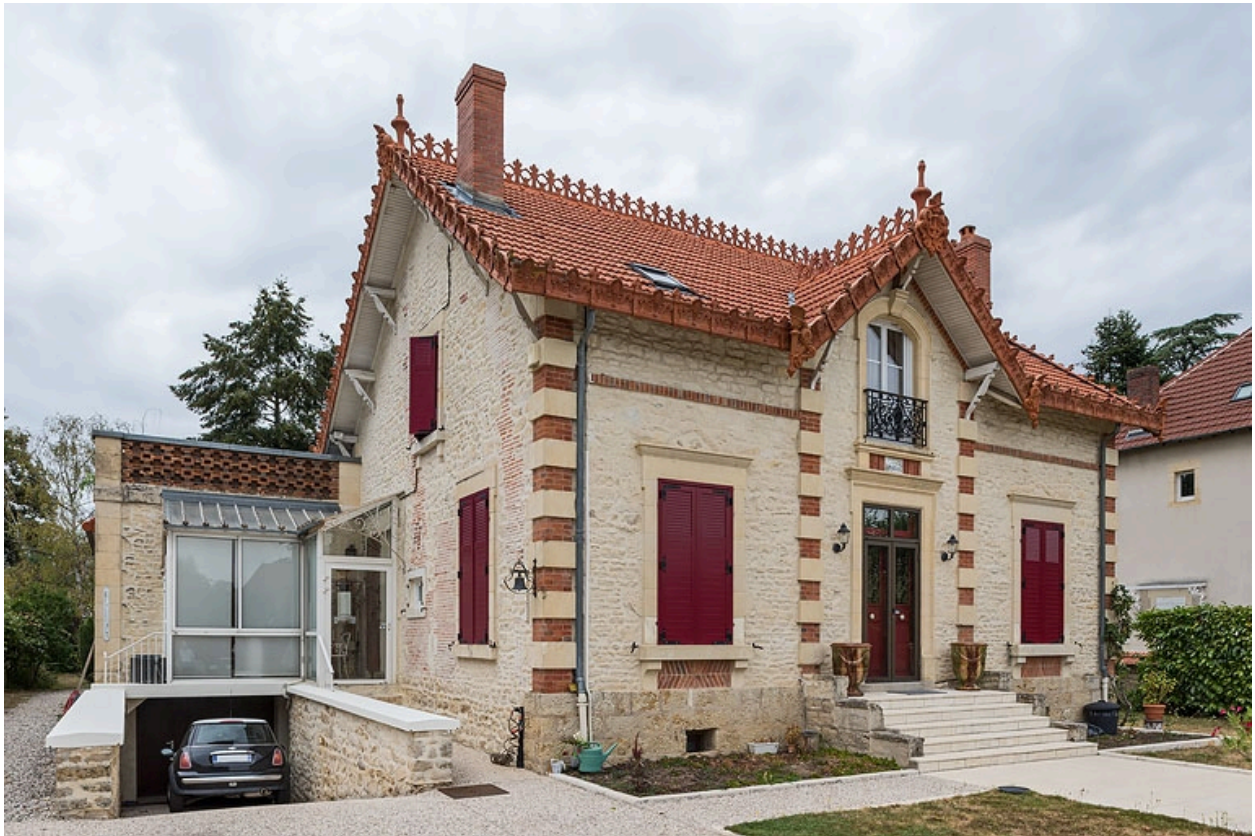
Façade principale, vue de trois quarts.
