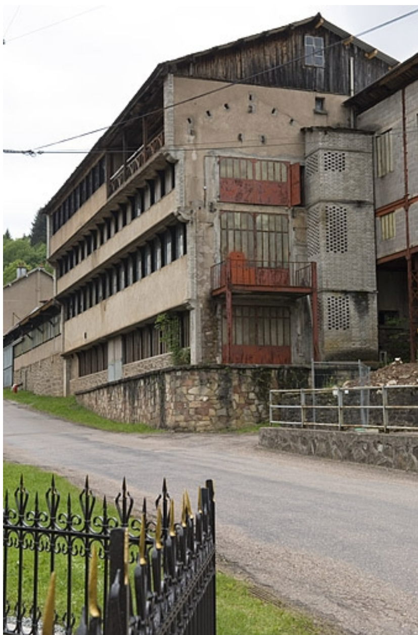
Elévation sud-est de l'atelier de fabrication primitif.
