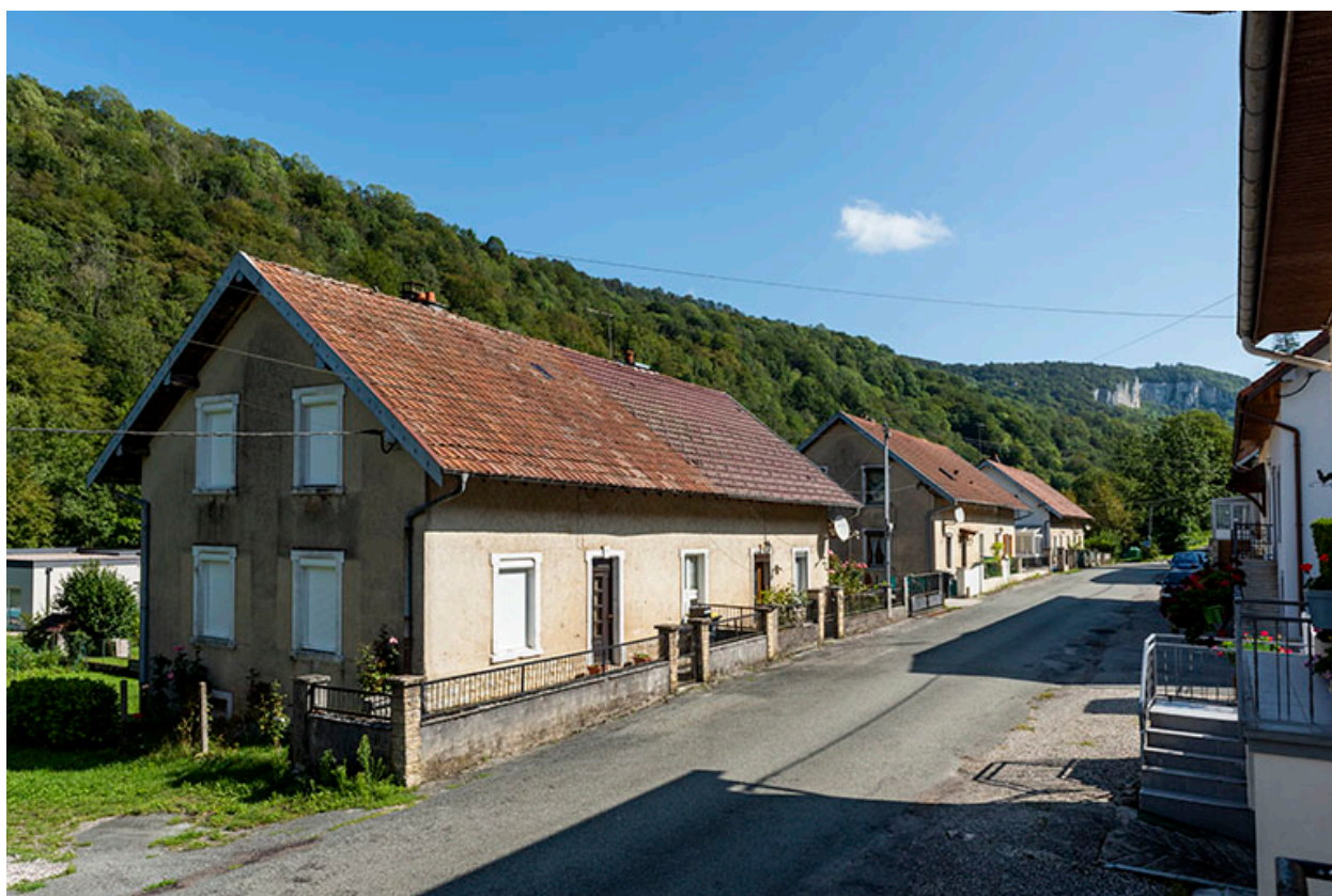
Cité Vauchamp : côté gauche de la rue, avec au premier plan la maison aux n° 123 et 124.
