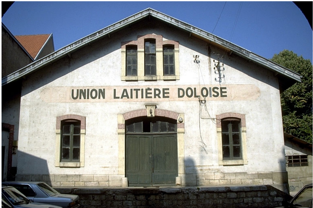
Façade antérieure de l'atelier de fabrication.
