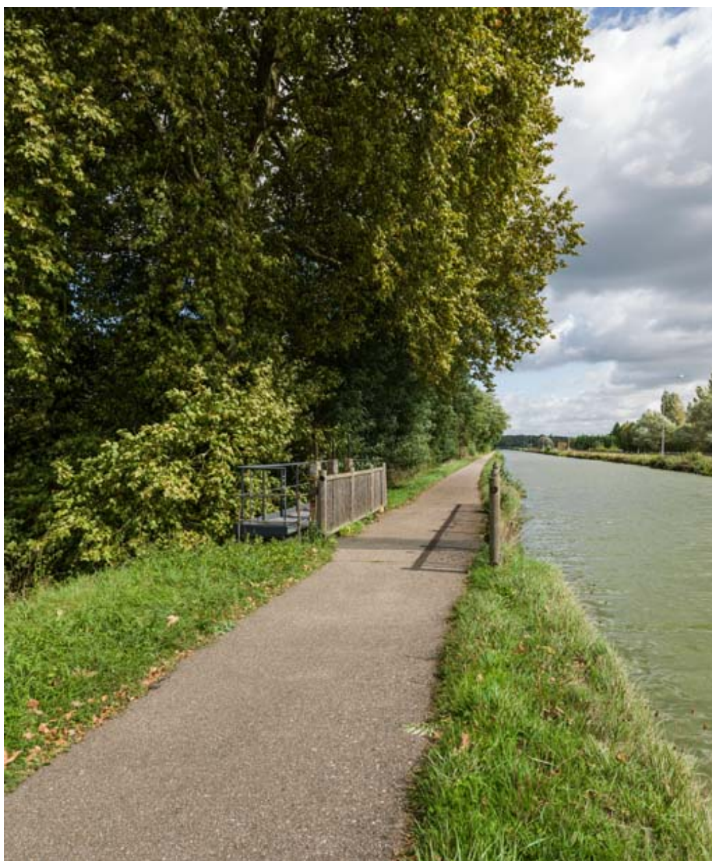
Vue du déversoir.
