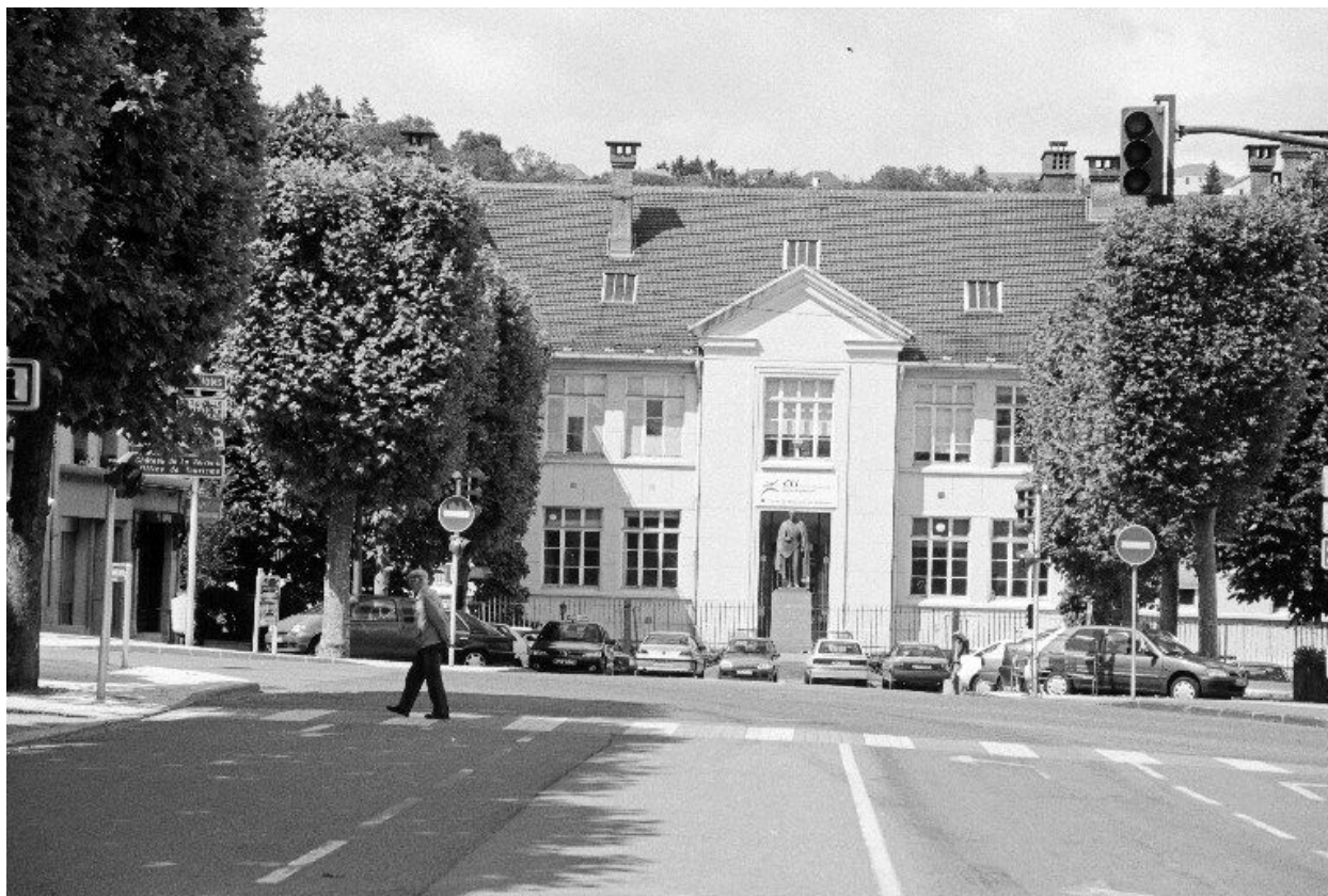
Façade antérieure du laboratoire.
