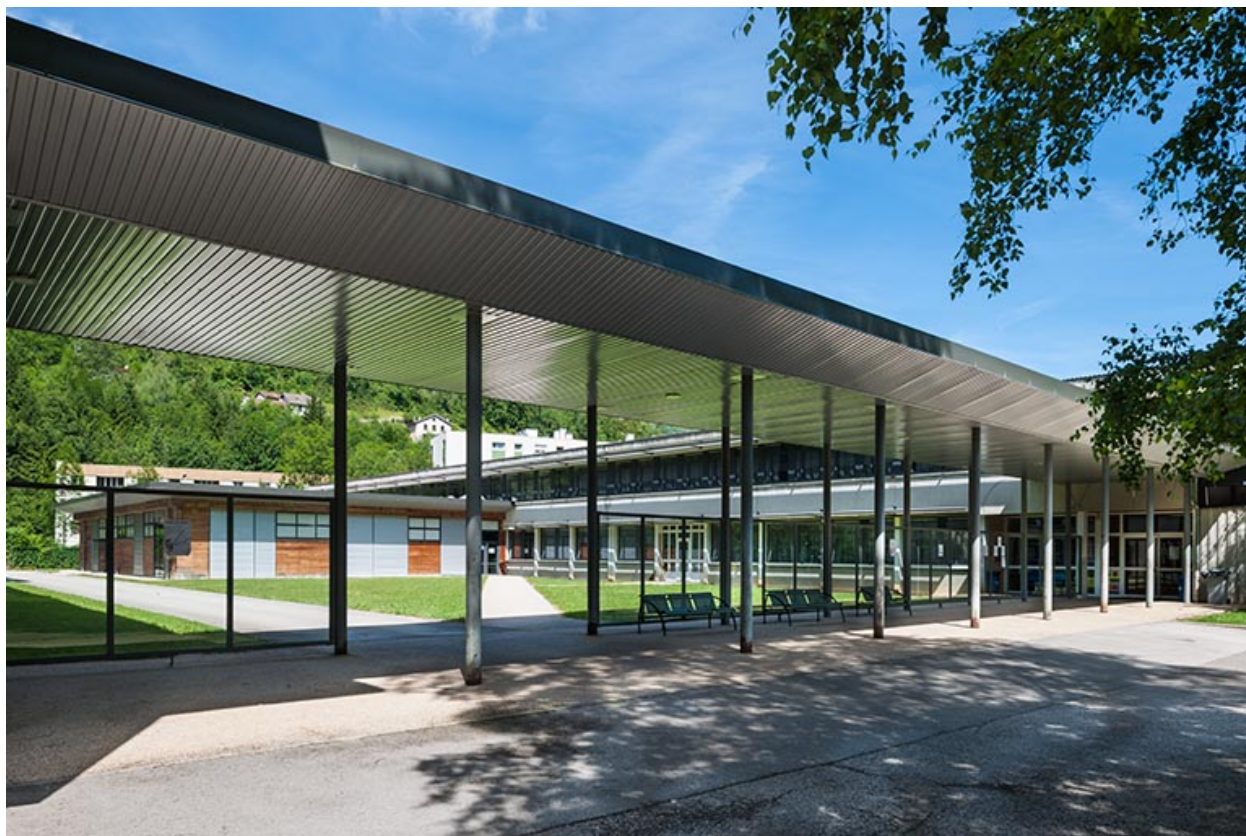
Passage couvert reliant l'atelier à l'externat tertiaire.
