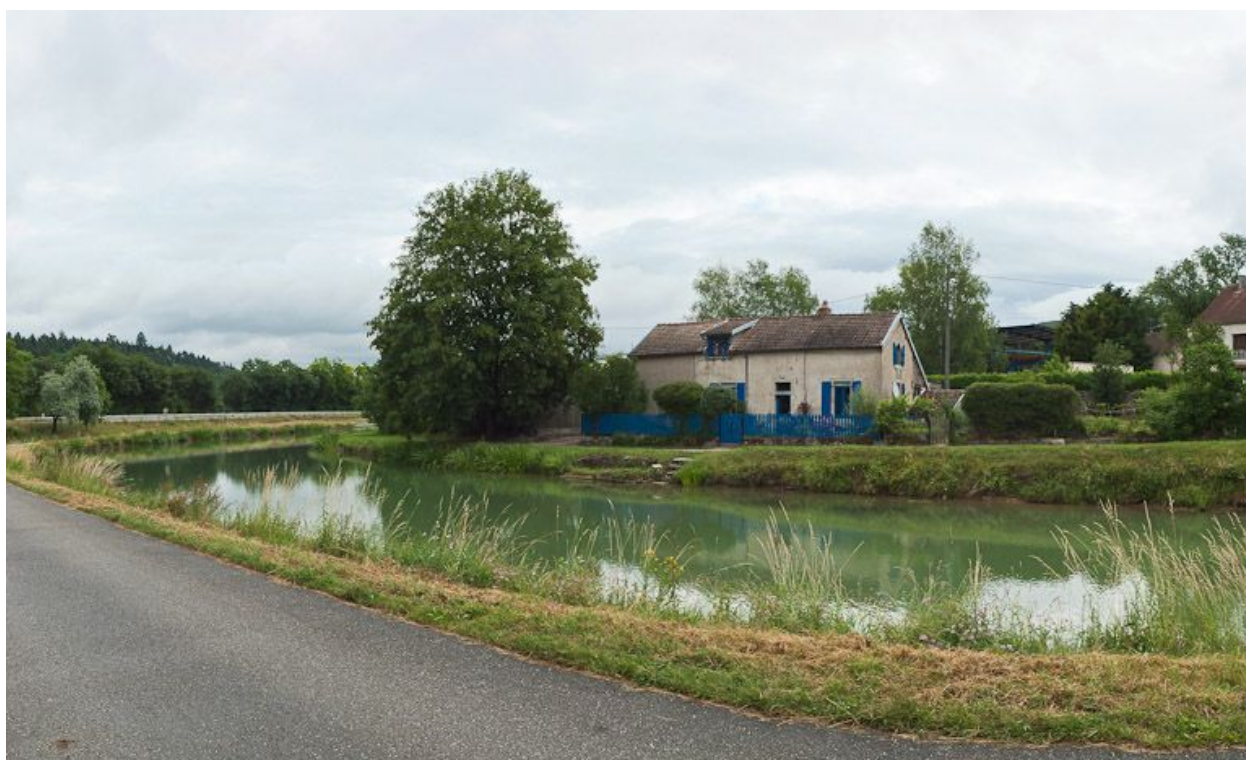
Vue de la maison de garde.
