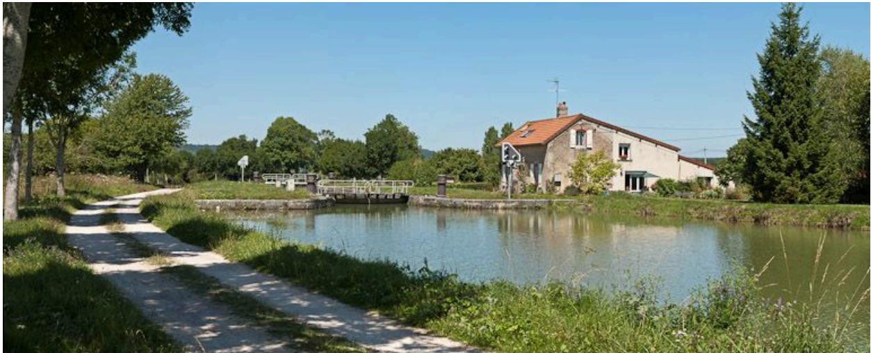
Site de l'écluse 05 du versant Yonne, dite de Pelleson, à Thoisy-le-Désert : vue d'ensemble.
