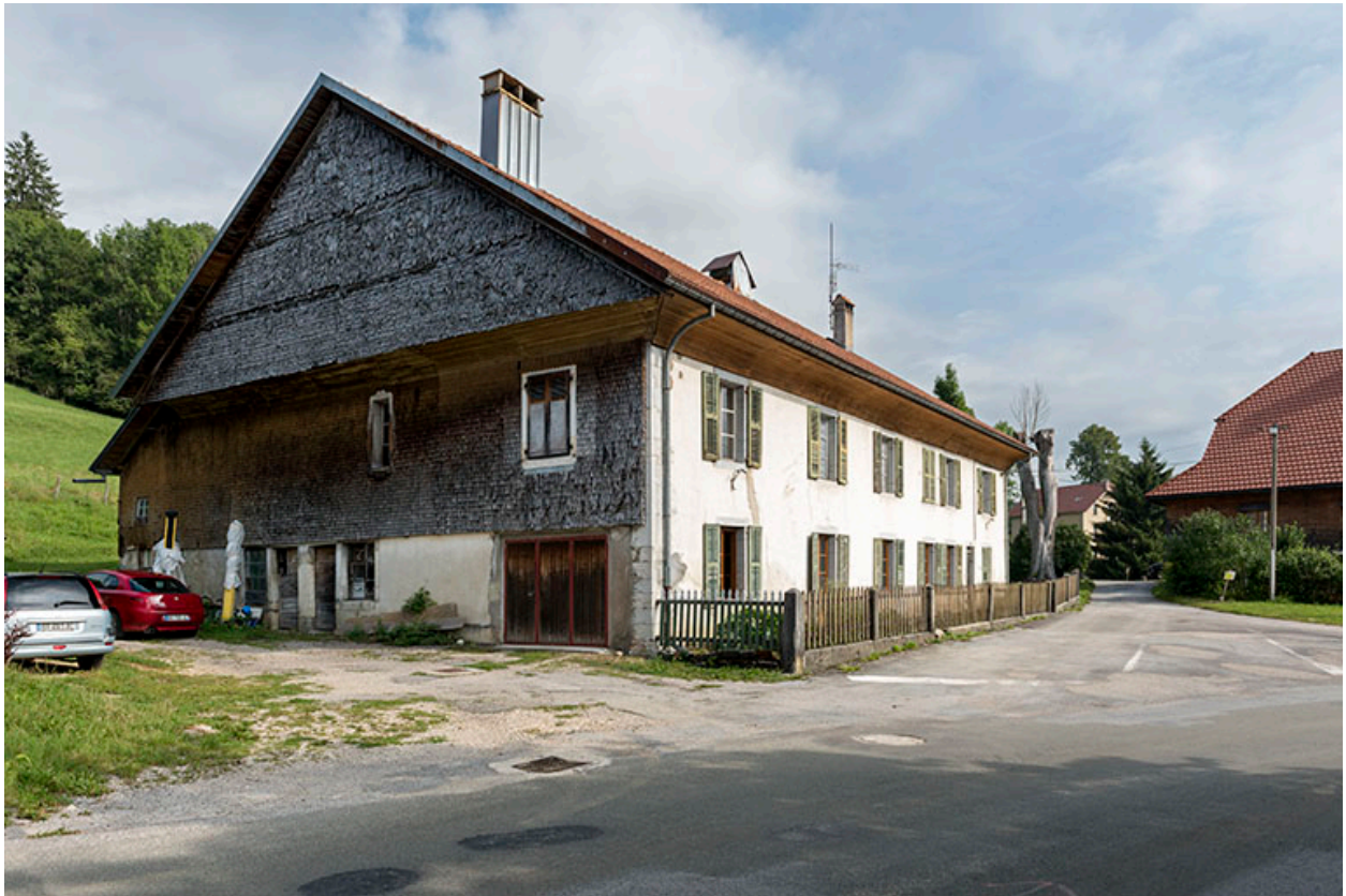
Façades antérieure et latérale gauche.
