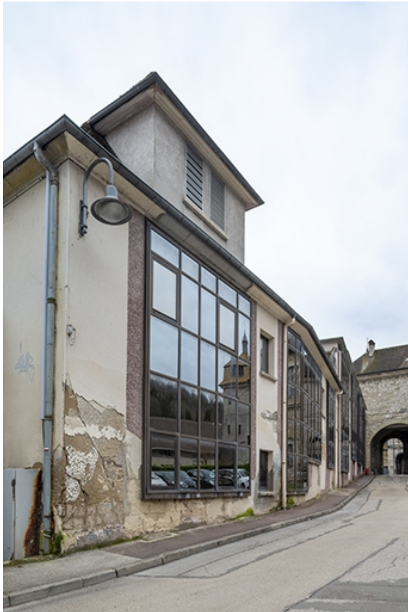
Façade sur la rue des Barres.
