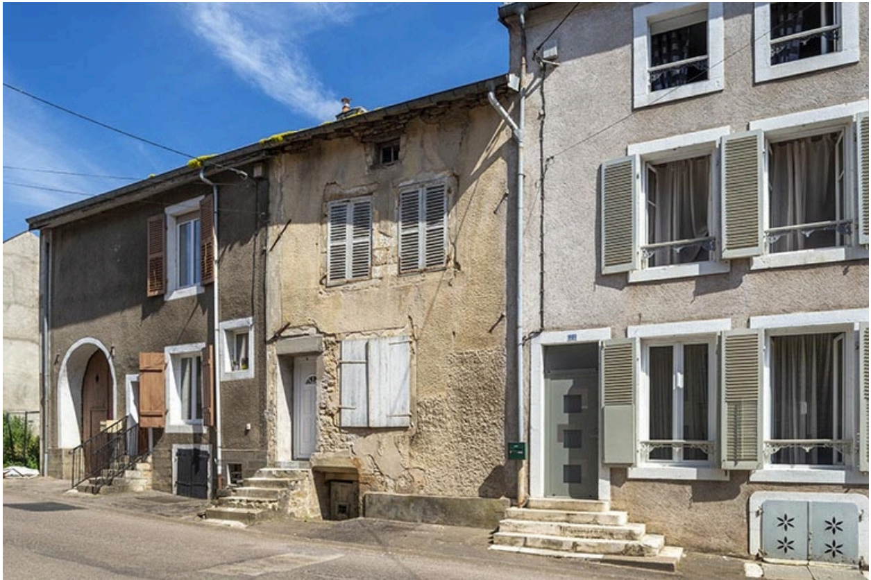
Rue Thiers, alignement du côté pair devant le n° 22, vue vers le nord-est.
