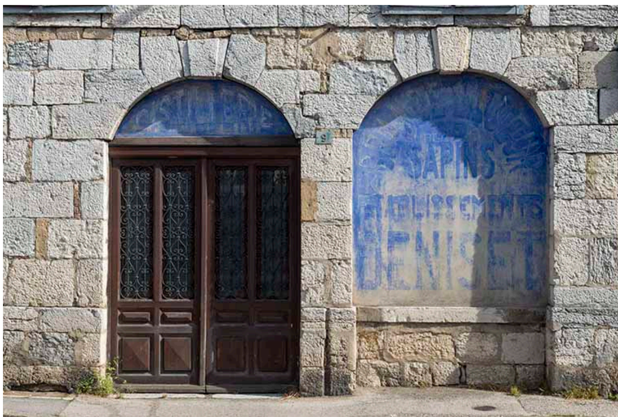
Détail de la façade ouest.
