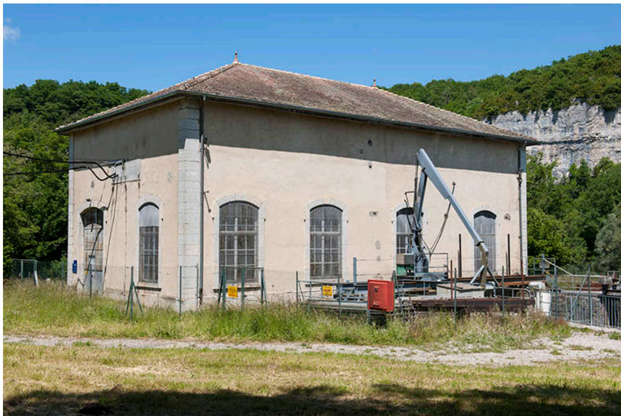
La centrale hydroélectrique vue de trois quarts.
