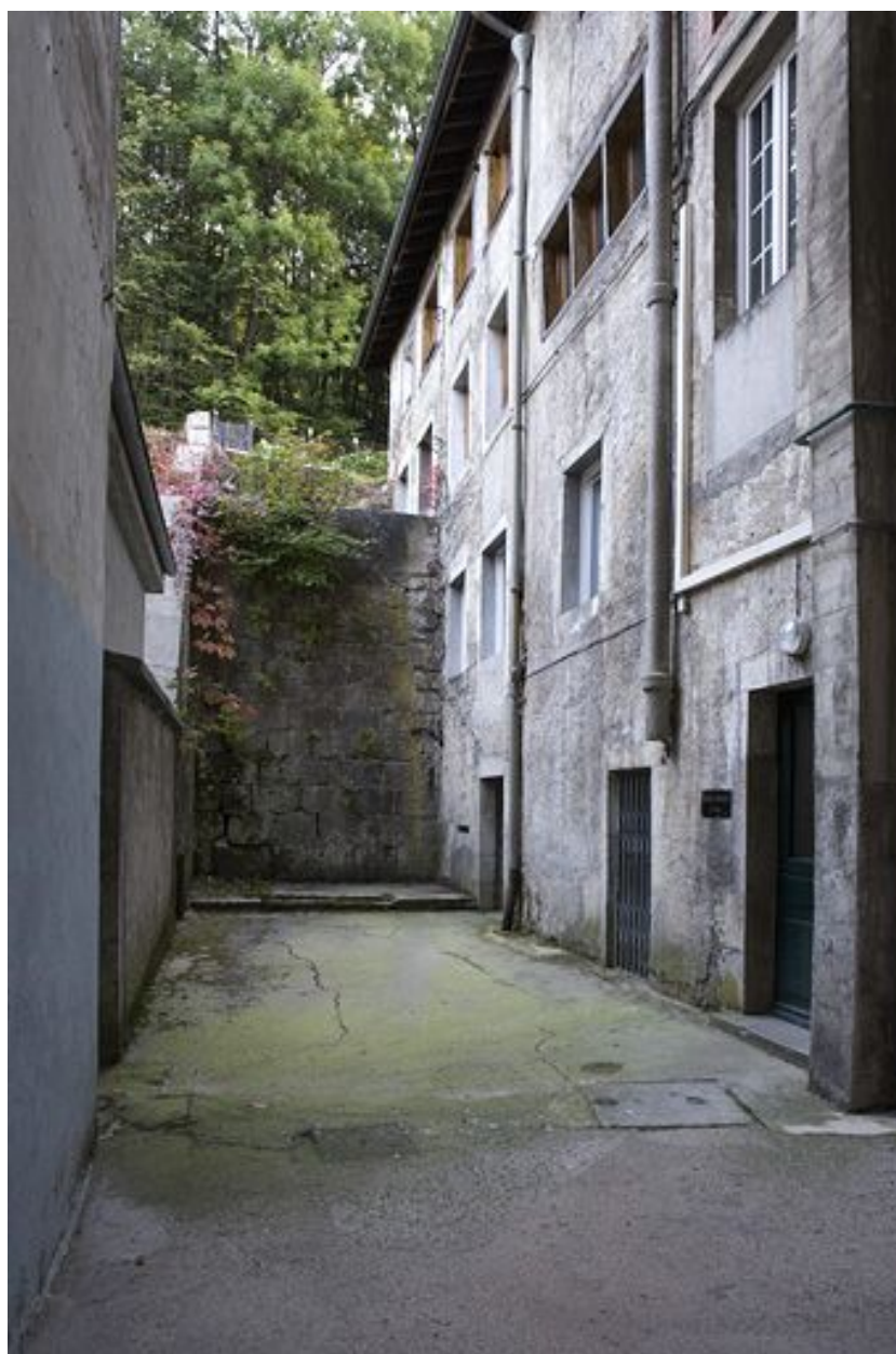
Cour, ancien atelier et mur de soutènement.
