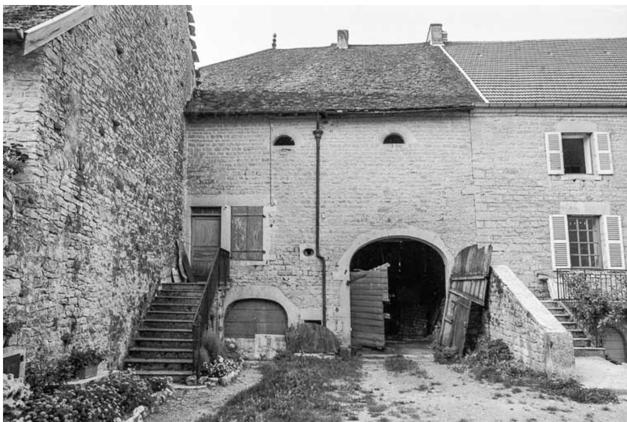
Ferme cadastrée AD 324 : façade antérieure.
