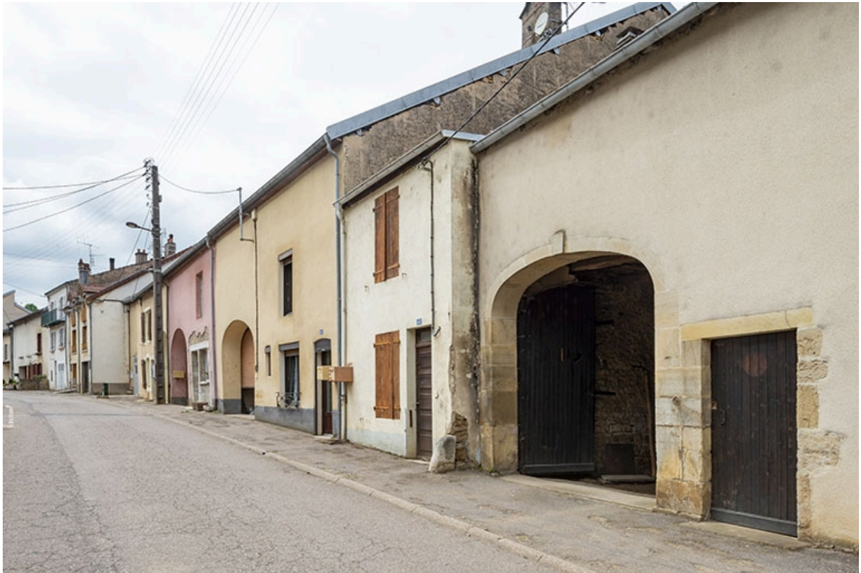
Rue Thiers, alignement du côté impair devant le n° 45, vue vers l'ouest.
