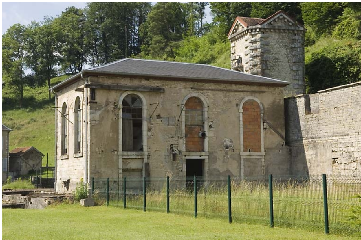
Façade ouest de la salle des machines.
