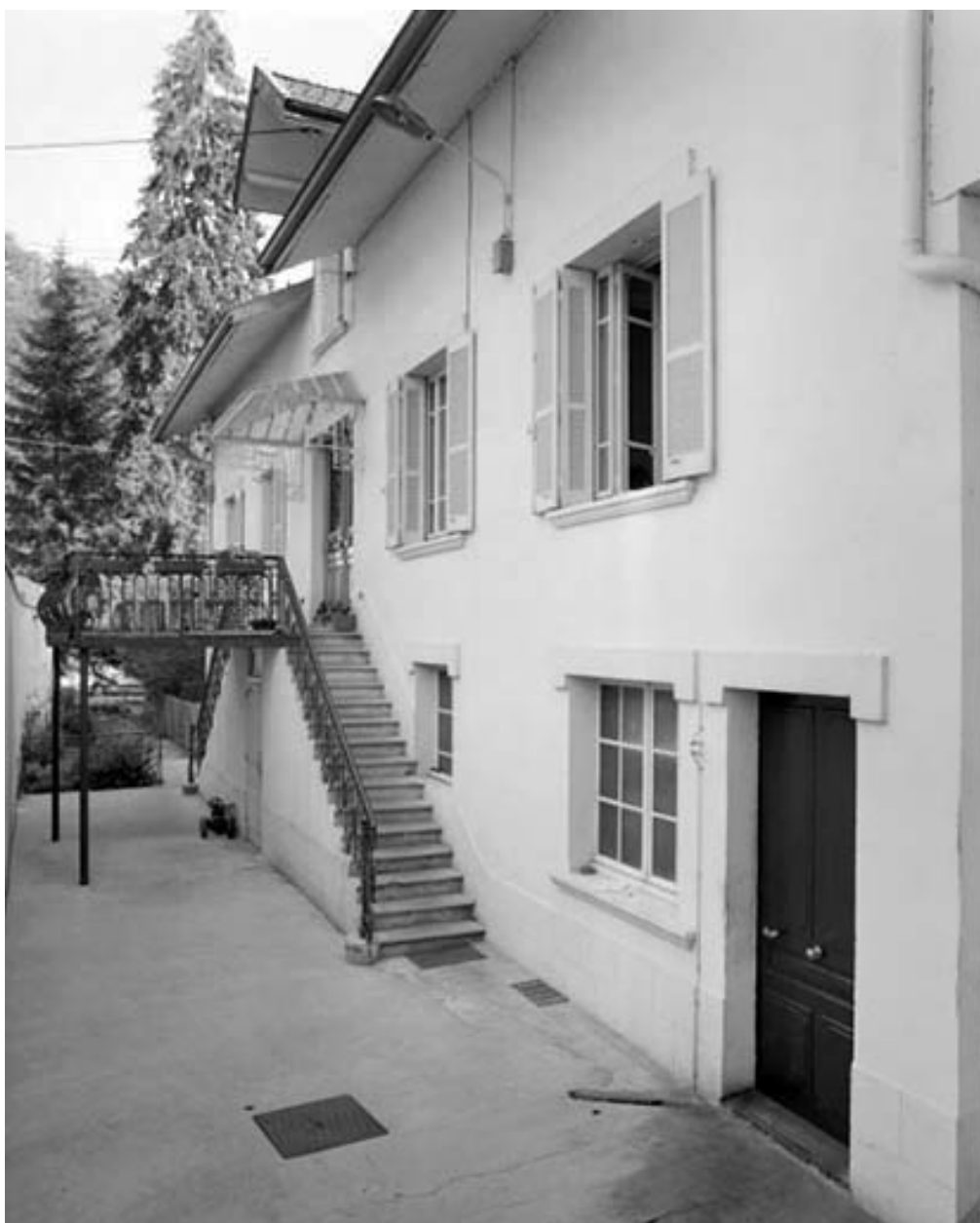
Façade sur cour du bâtiment de 1927.
