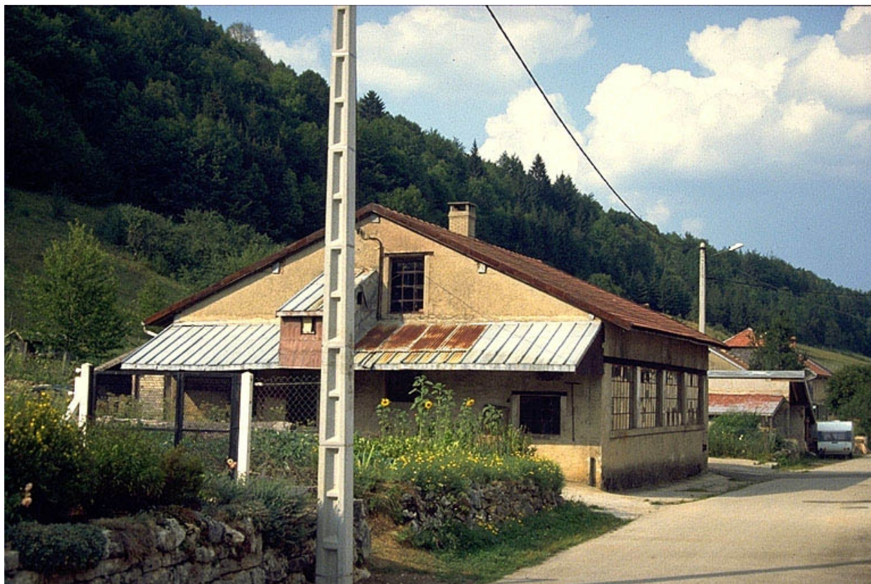
Façades antérieure et latérale droite.
