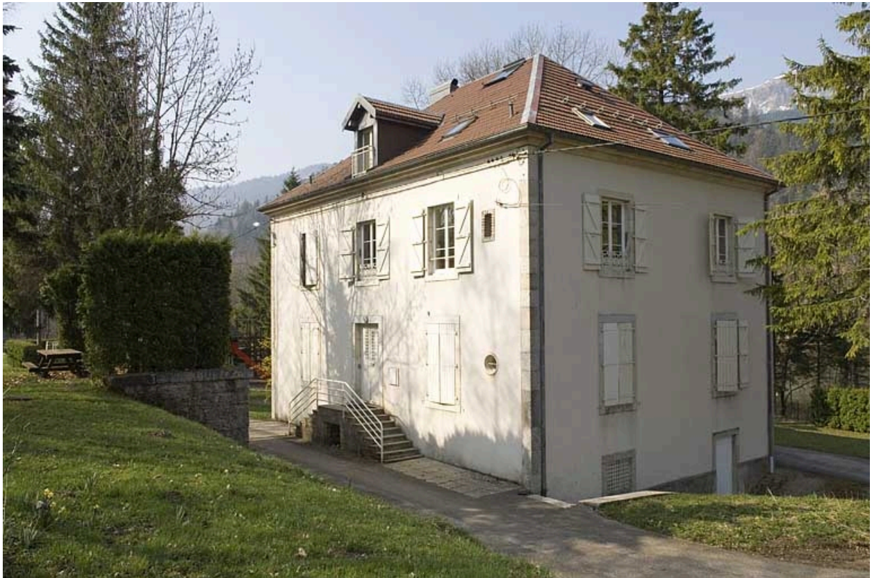
Logement patronal dit le "Petit Château" (21 rue des Forges, 2020 AI 44).
