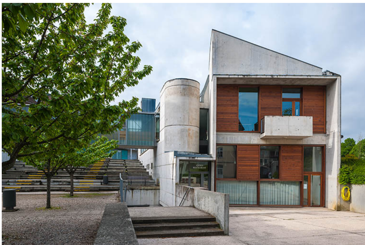
Pignon nord du restaurant d'application.
