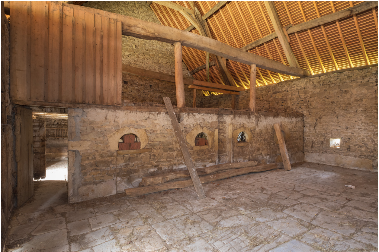
Vue intérieure de la remise du char à foin, avec ses murs percés de feurons.
