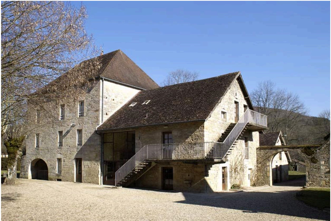
Ancien moulin à eau (élévation ouest) et bâtiment annexe.
