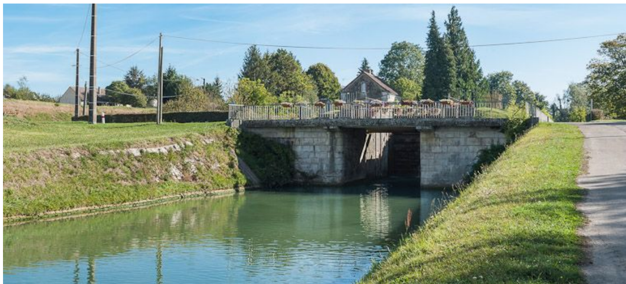
Le pont vu d'aval.
