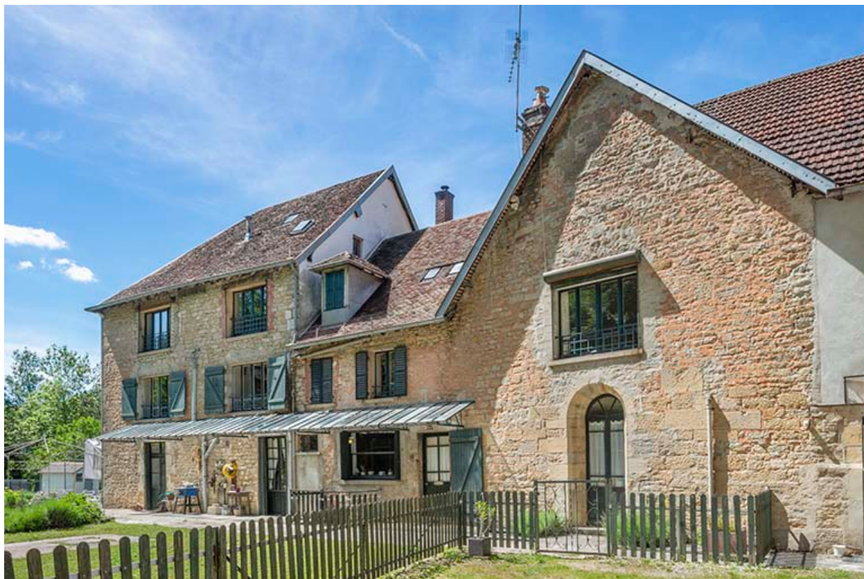
Façades orientales depuis l'est.
