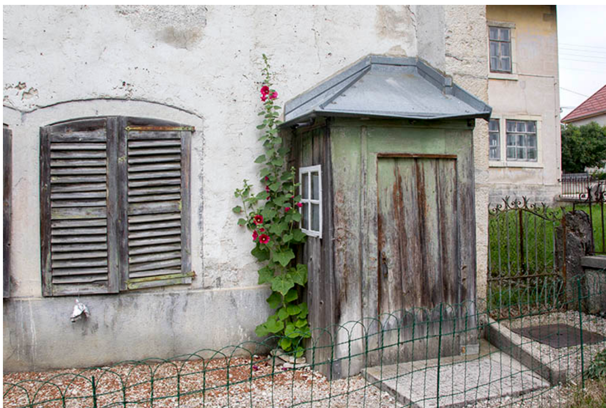
Façade antérieure : fenêtre du rez-de-chaussée et édicule.
