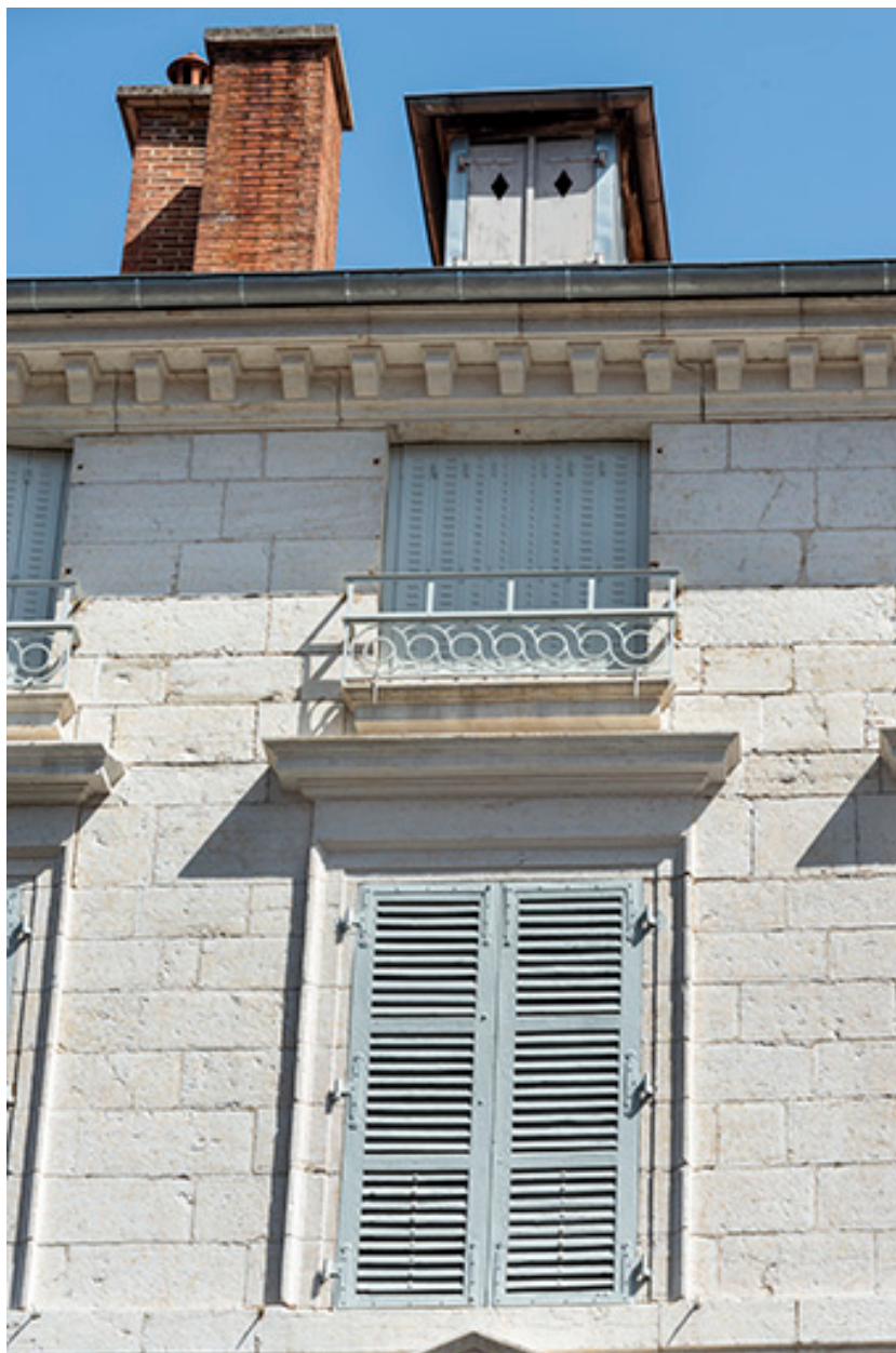
Façade antérieure. Fenêtres des étages supérieurs.
