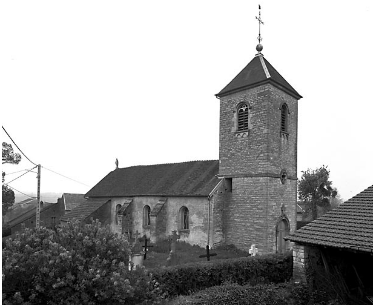
Clocher et façade latérale gauche.
