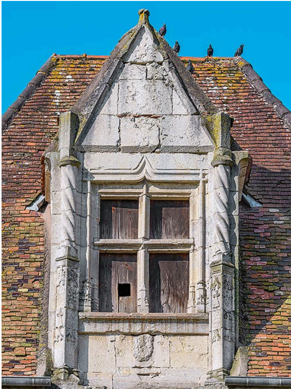
Vue de la baie à meneau.
