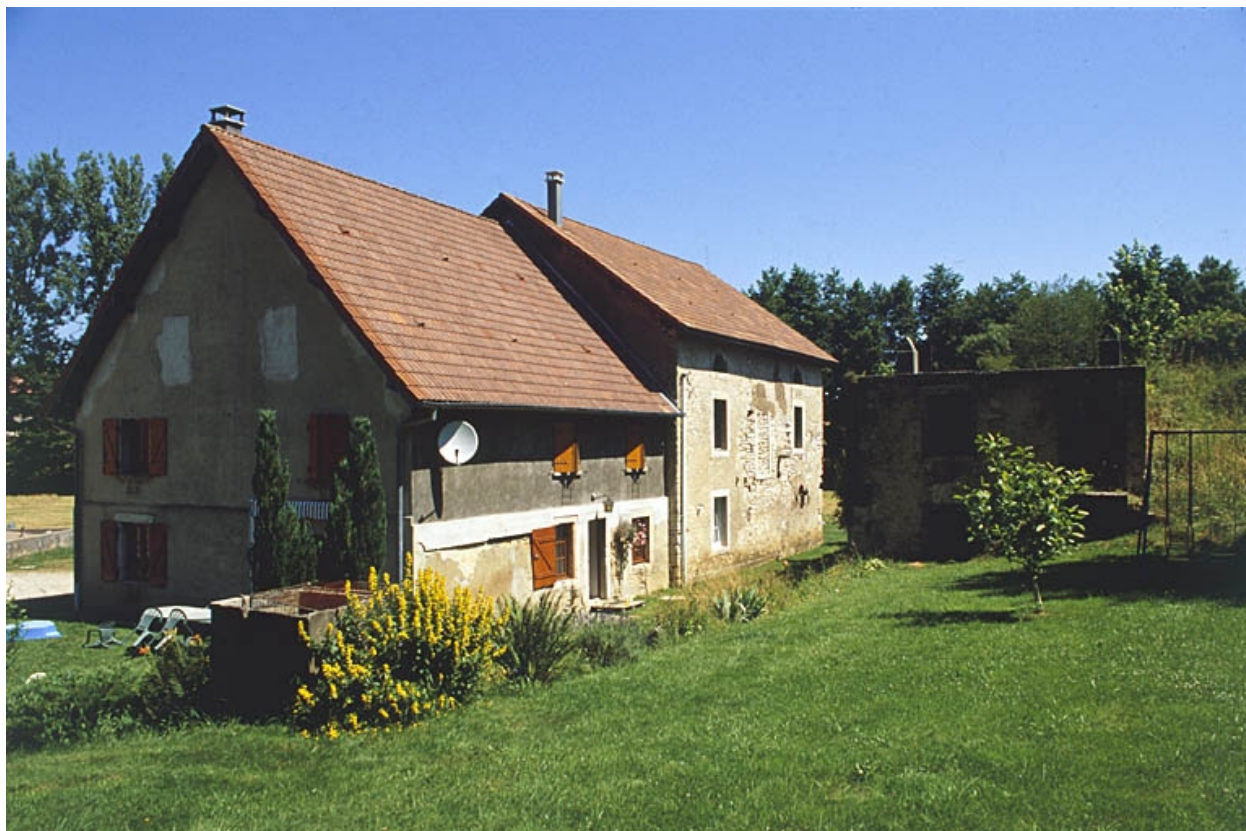
Vue de trois quarts arrière. De gauche à droite : logement, moulin et chambre d'eau.
