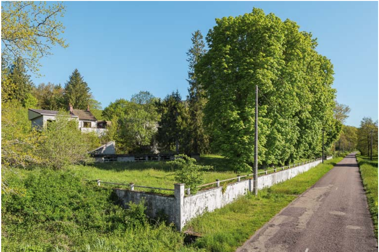
Vue de trois-quarts depuis le sud-ouest.
