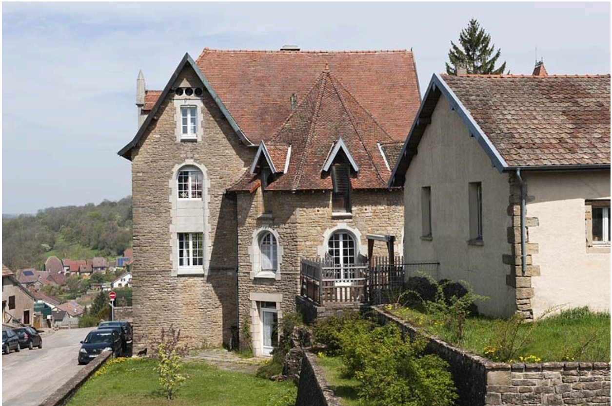
Bâtiment (G), côté rue.
