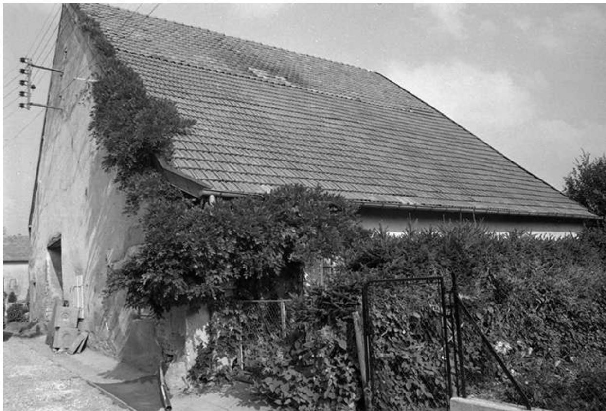
Maison située rue de l'Eglise.
