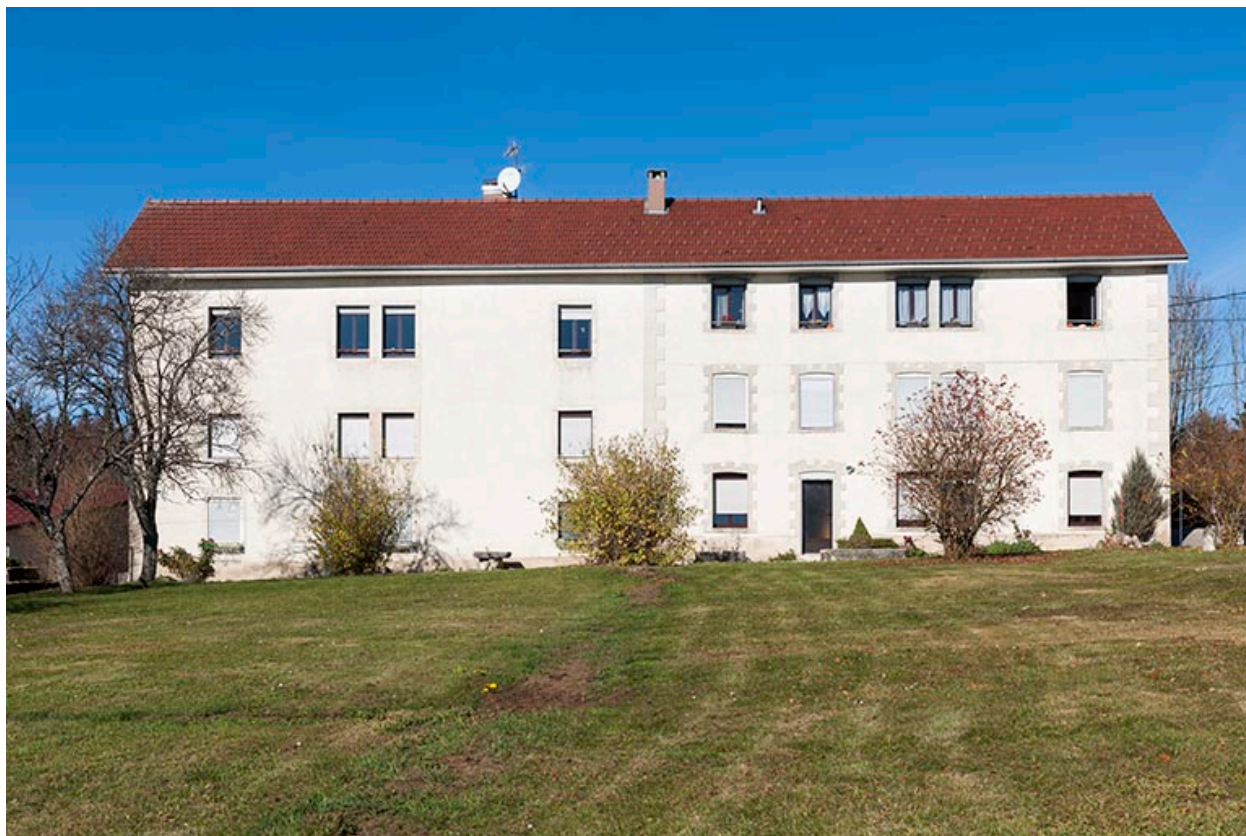
Ferme (à gauche) et atelier (à droite).
