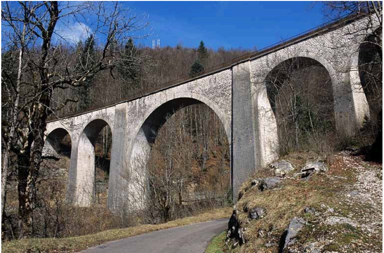
Elévation sud (aval), vue de trois quarts droite.
