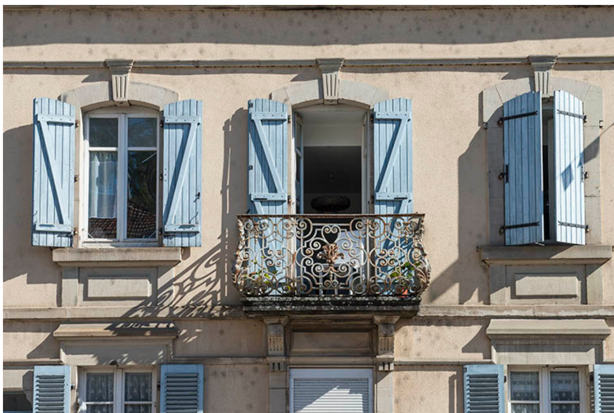
Etage carré, façade antérieure.
