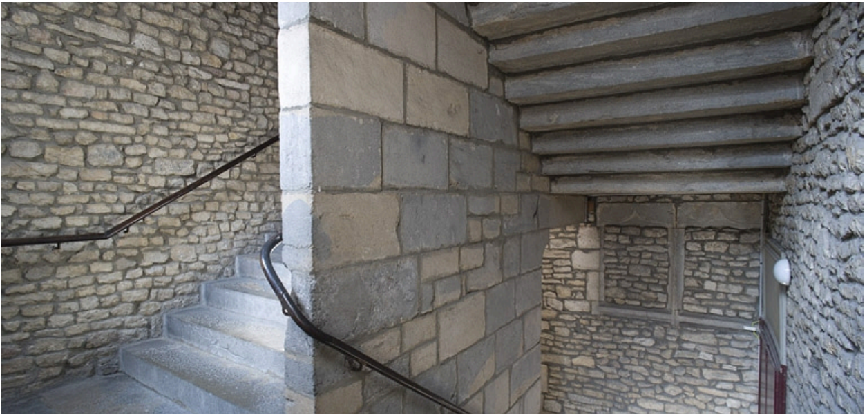
Détail de l'escalier principal en maçonnerie.
