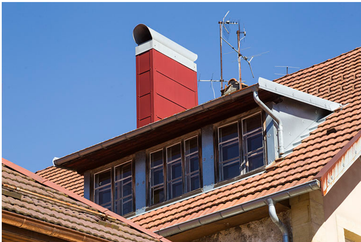
Lucarne sur le versant sud-ouest.
