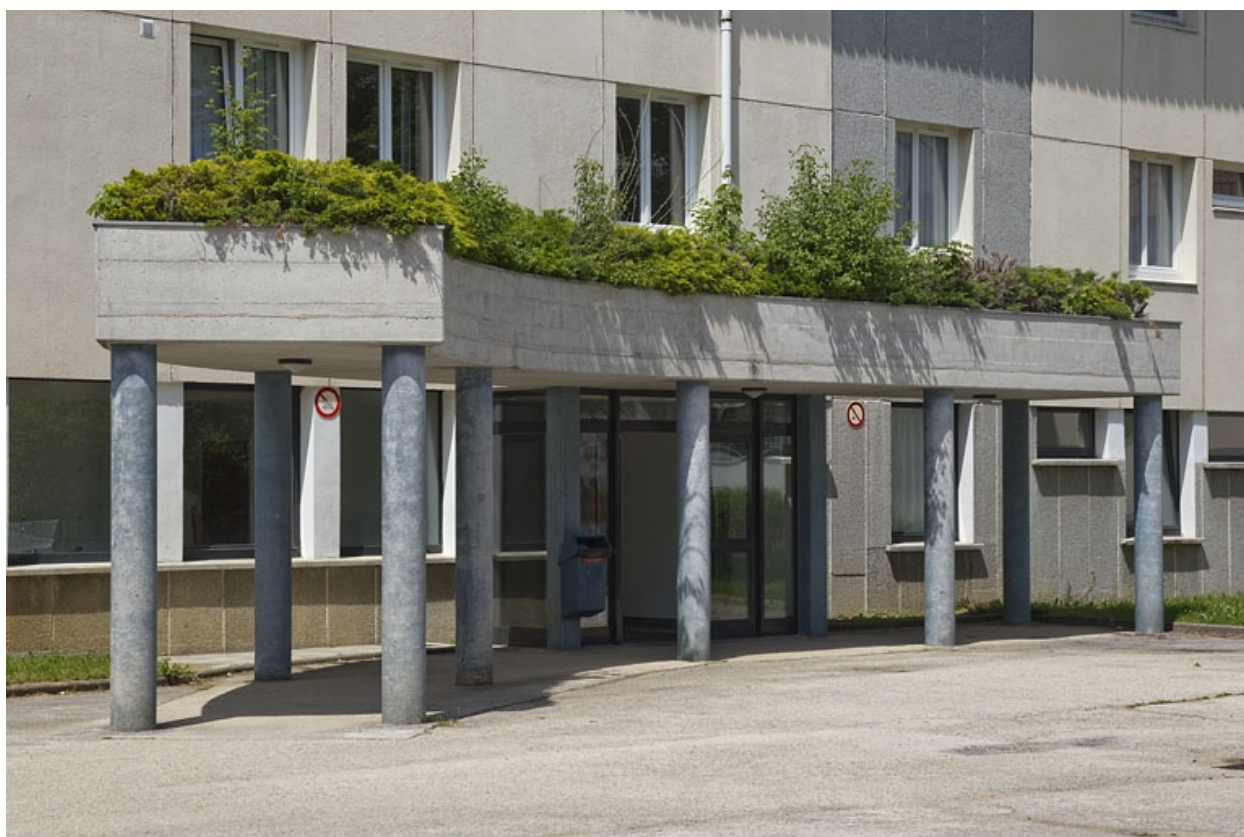
Bâtiment de l'infirmerie : portique.
