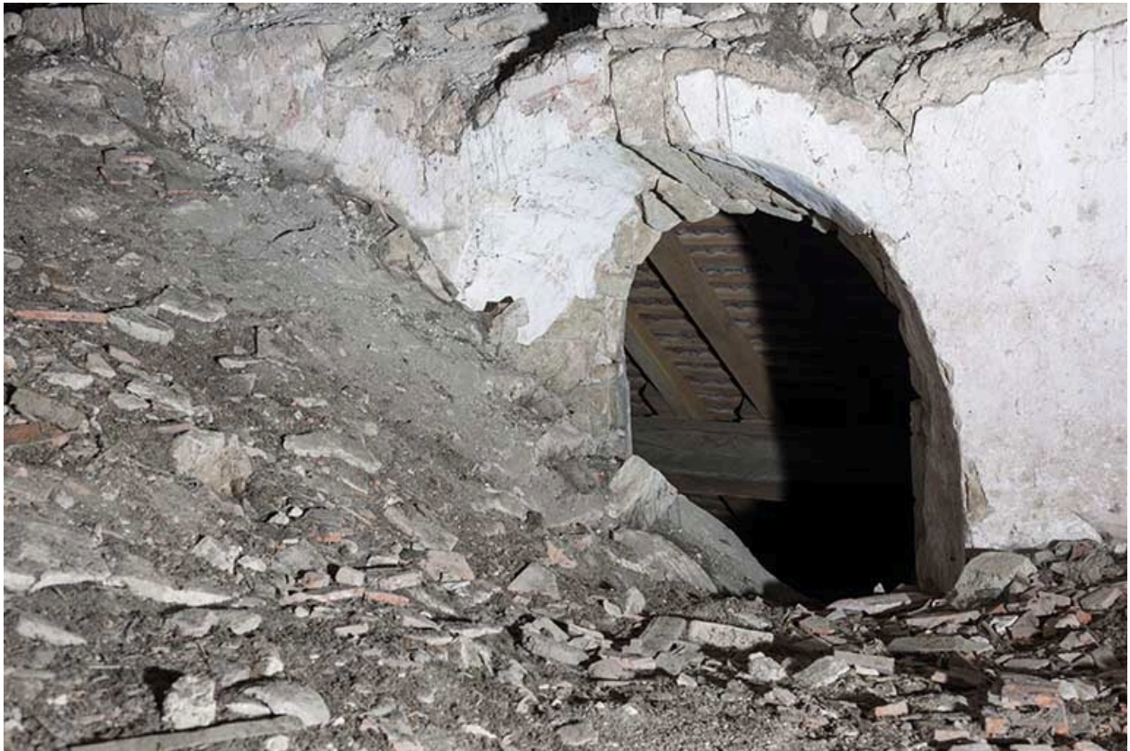
Ancienne baie au-dessus de la voûte.
