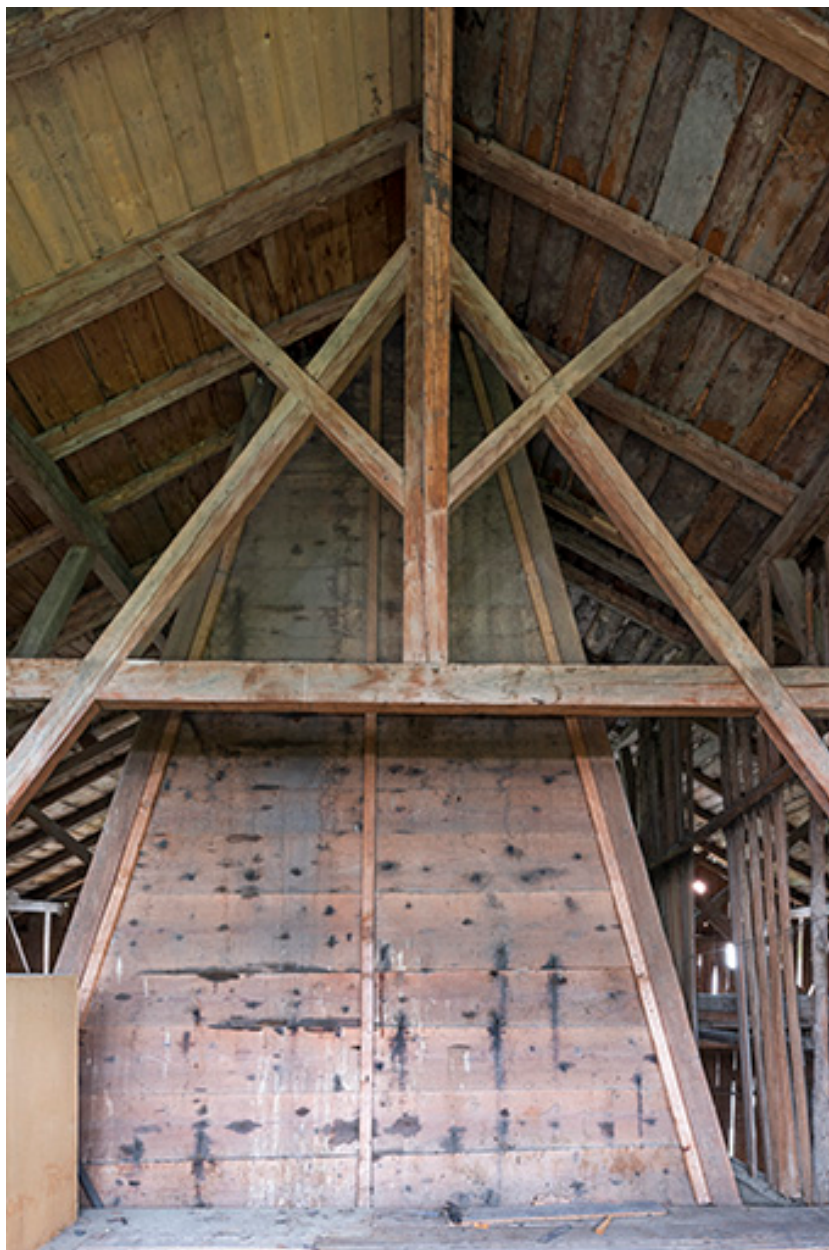
Intérieur, grange : hotte du "tué" central et charpente.
