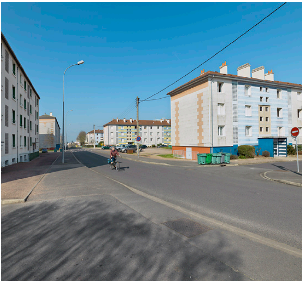
Vue générale depuis le nord de l'avenue de la Paix en direction de l'ouest.
