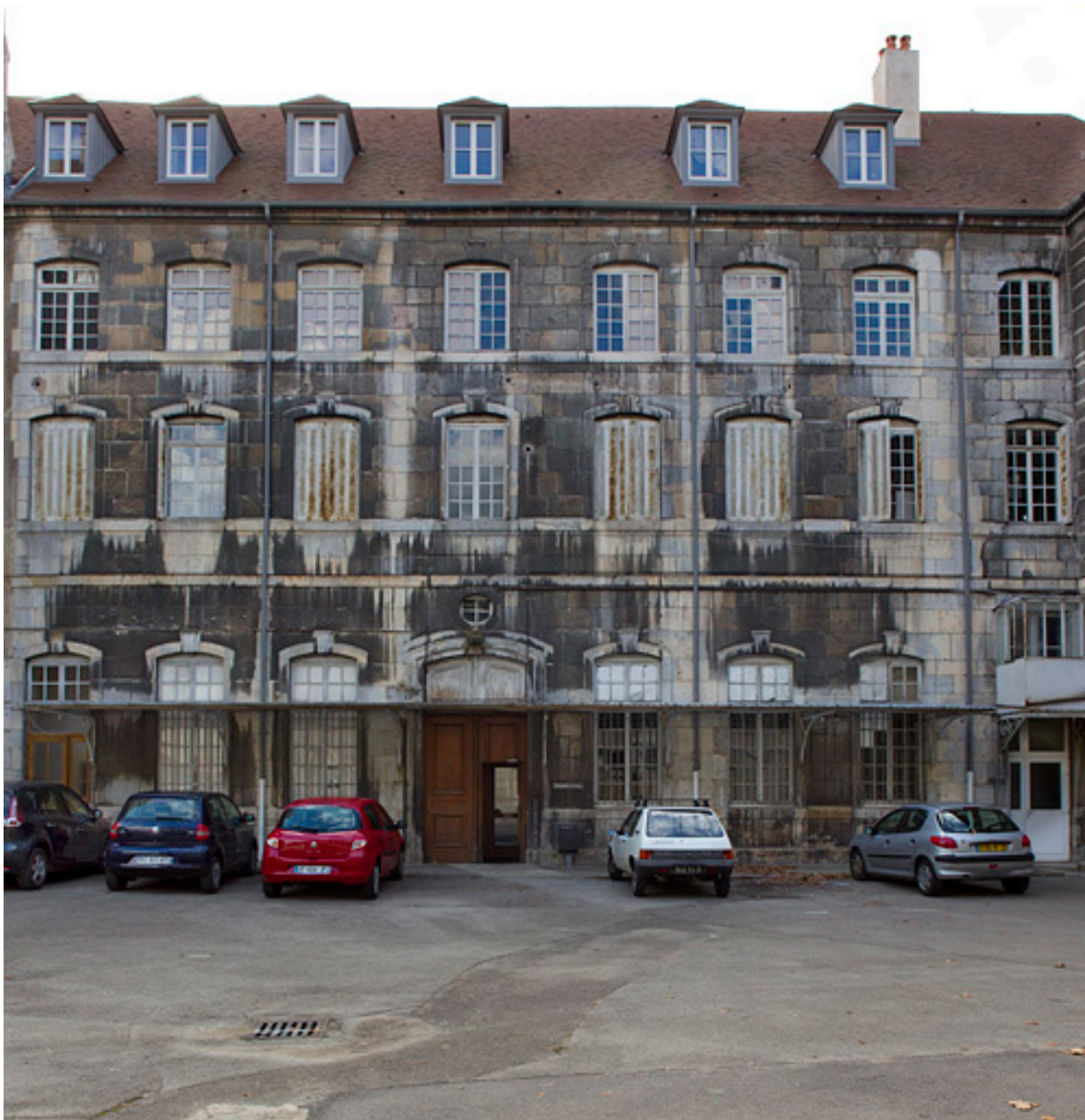
Façade latérale du bâtiment Ducat.
