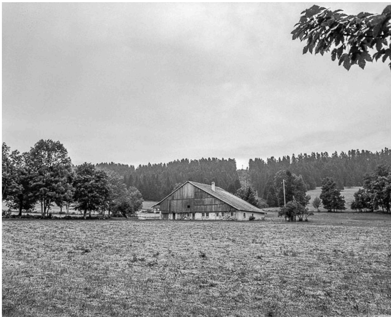
Ferme située au lieu-dit Combe d'Abondance, cadastrée B1 177 : vue d'ensemble.
