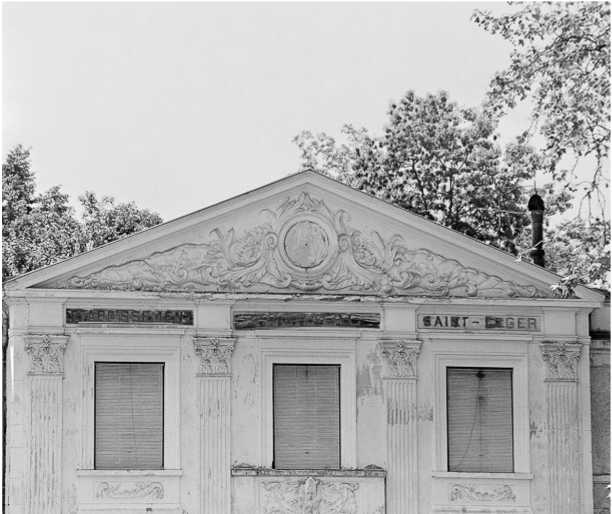
Façade antérieure, avant-corps, détail, fronton.
