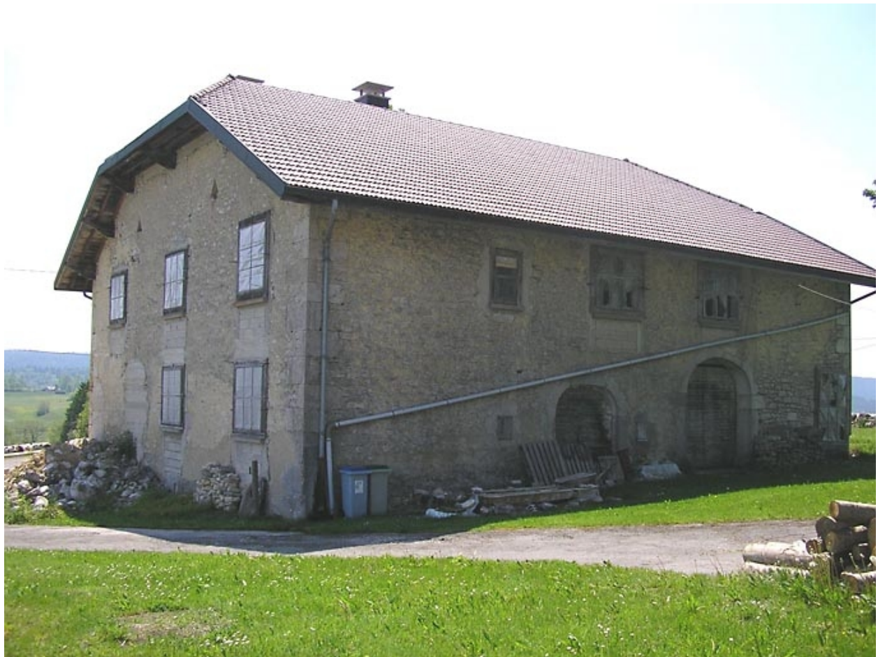
Pignon nord-est vu de trois quarts.
