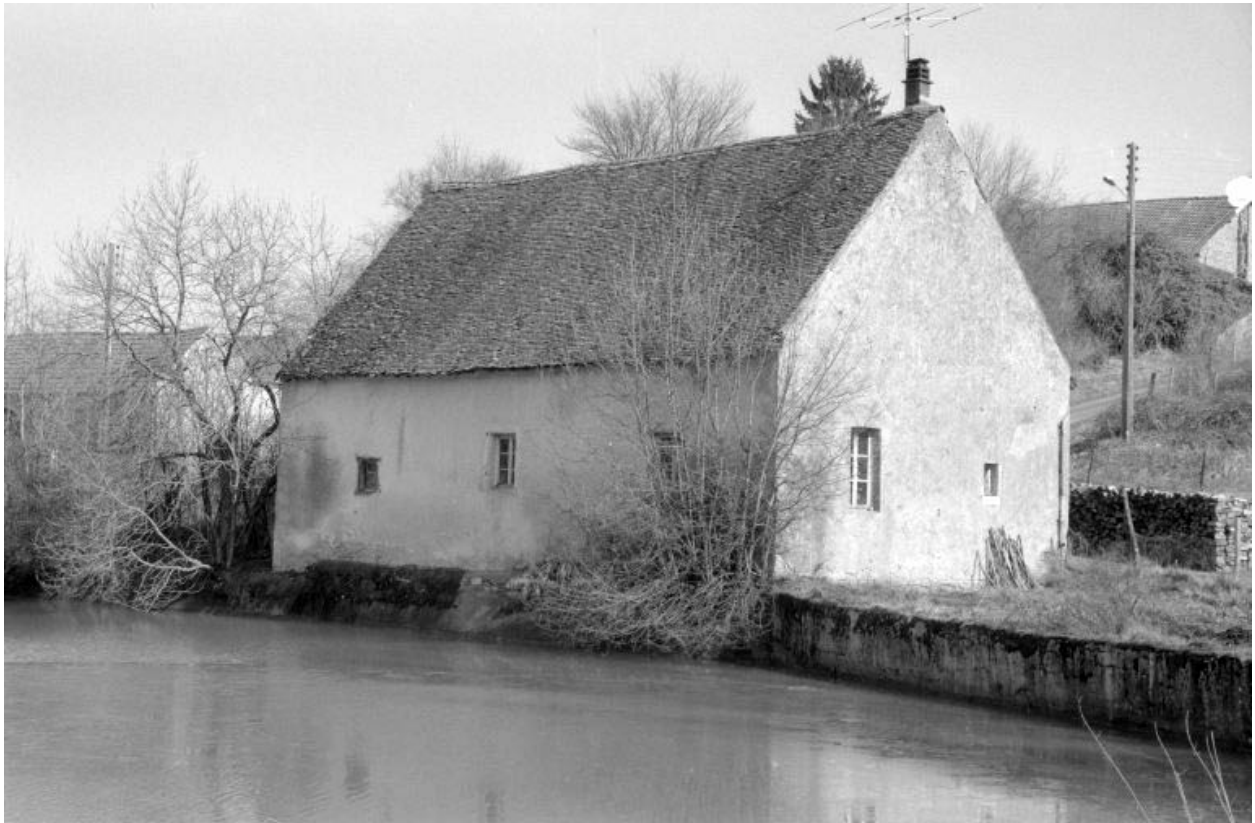
Façades postérieure et latérale gauche du logement.
